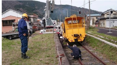
●八東駅での車両設置風景
